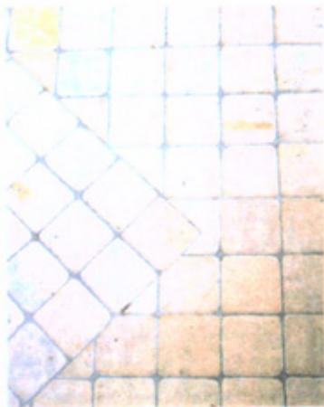
*I ciotoli di marmo, dall'aspetto anticato ottenuto attraverso una particolare lavorazione del materiale, sono stati posati secondo due schemi coesistenti: il primo denota il perimetro della stanza ed è caratterizzato da un allineamento degli elementi a corsi paralleli, il secondo campisce la superficie del pavimento per mezzo di una trama a linee oblique*
